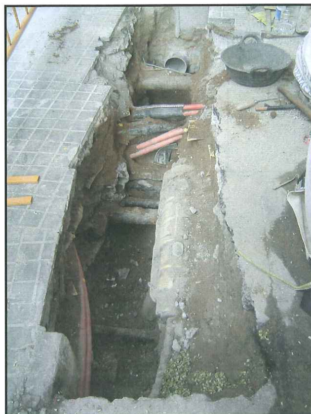
Fig 6. Imatge de les infraestructures elèctriques recents i les canalitzacions modernes.
