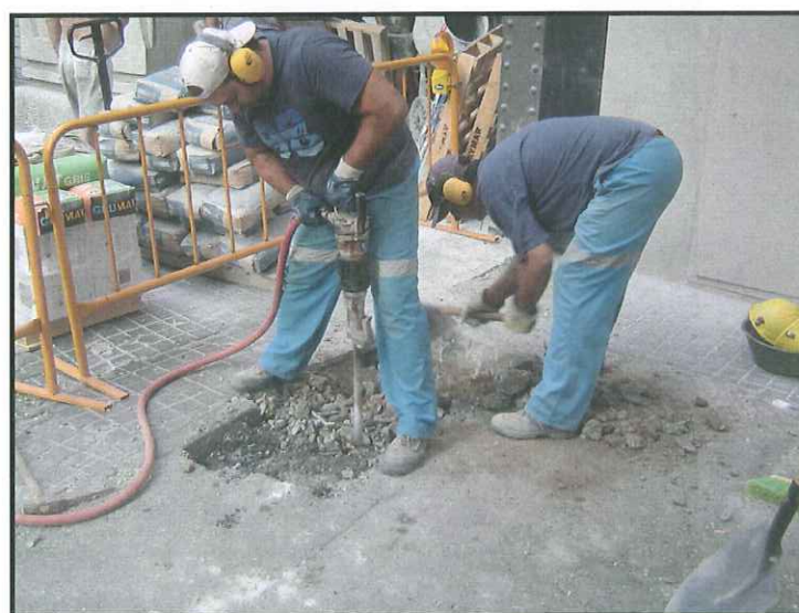
Fig 4. Inici de les tasques d'excavació de la rasa.
